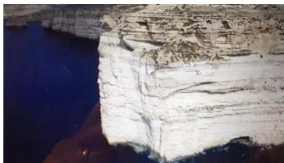
Fig. 18 - Veduta da drone del versante occidentale del promontorio di Wardija, che mette in evidenza le zone di erosione della scogliera.
