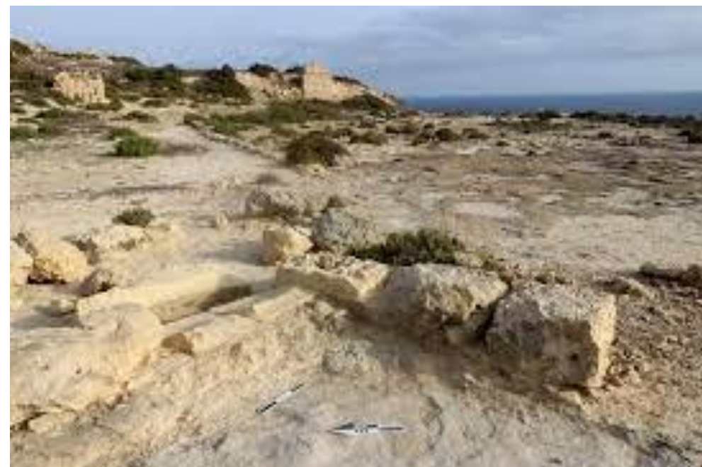
Fig. 13 - Resti di pavimenti in marna calcarea mista a frammenti di marmo conservati presso l'angolo sud-orientale del tempio.
